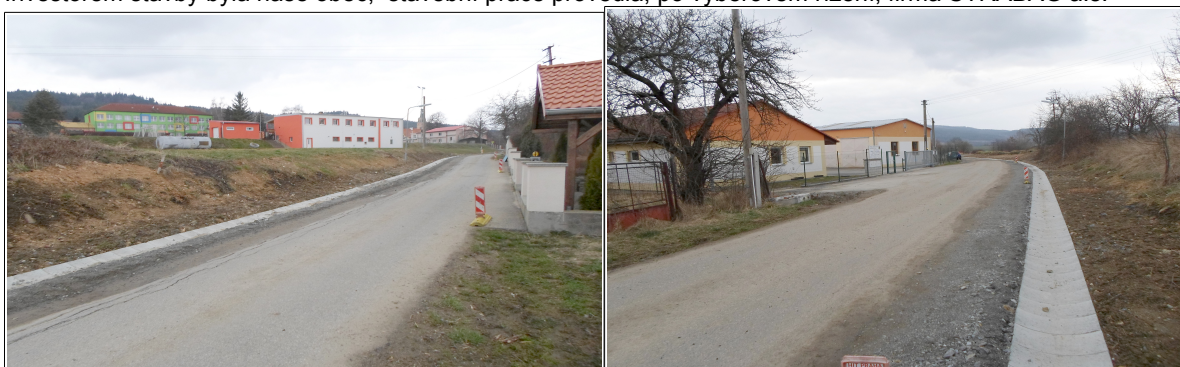
fota: nově provedený kanalizační svod a nově vsazené rigoly „Na Bělíčce“ (foto z 28.3. 2015) JB, JM, IR
